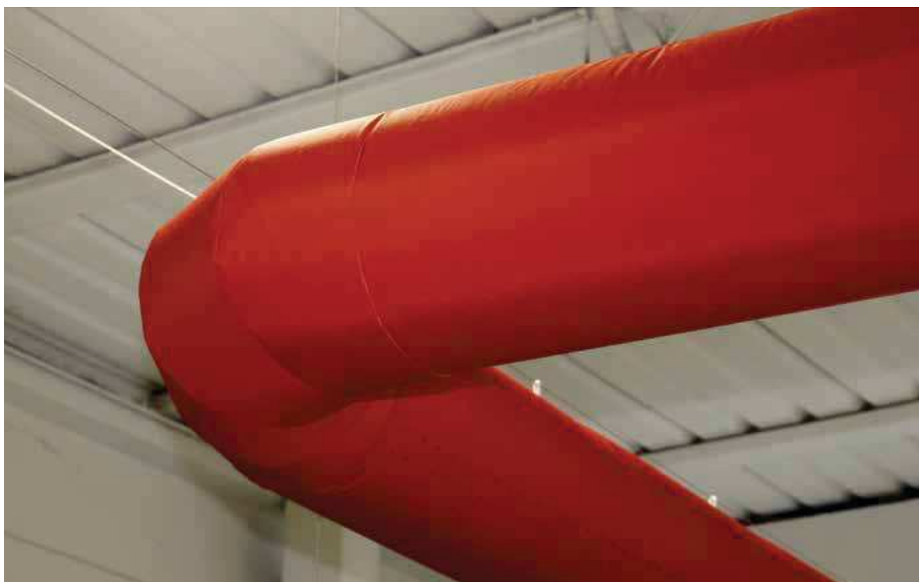
Coude 90° pour gaine DHI TEXTILE DHI TEXTILE diffuser bend 90°
