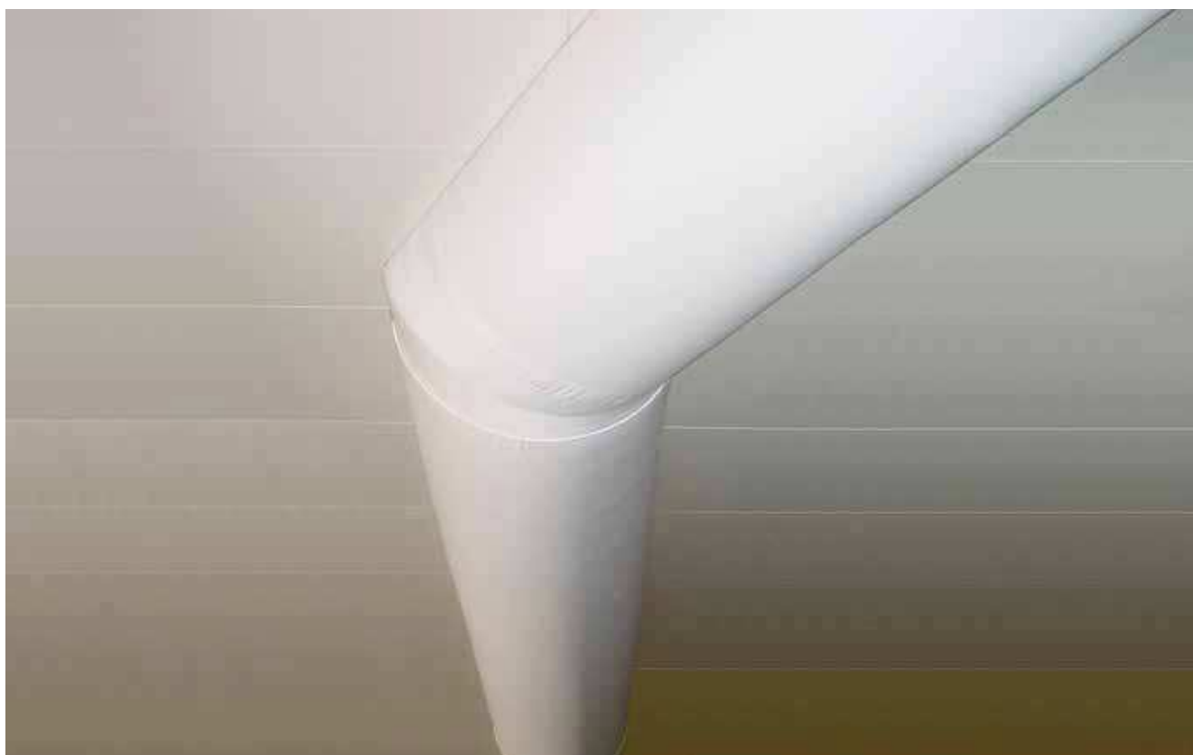
Diffuseur DHI TEXTILE DHI TEXTILE diffuser
