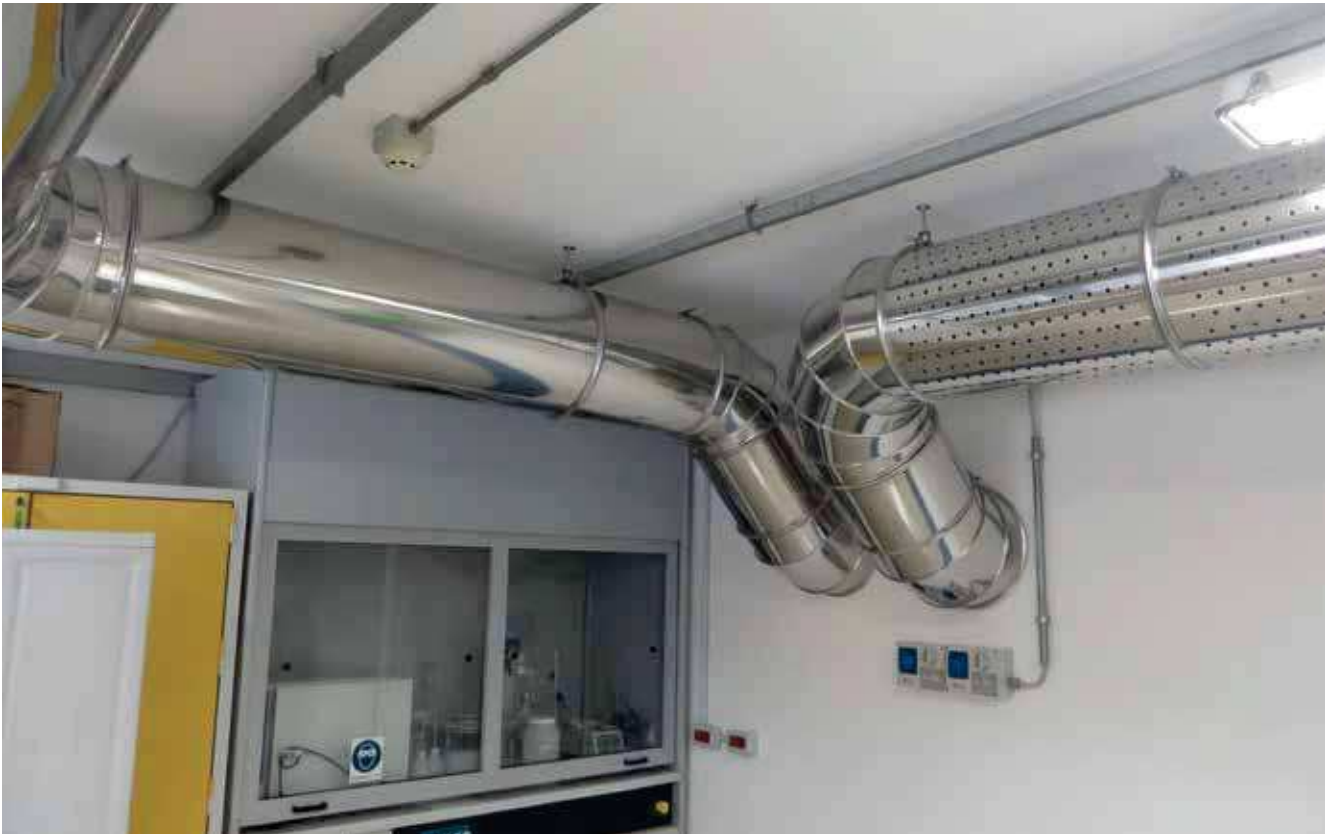
Coude 45° pour gaine DHI METAL DHI METAL diffuser bend 45°
