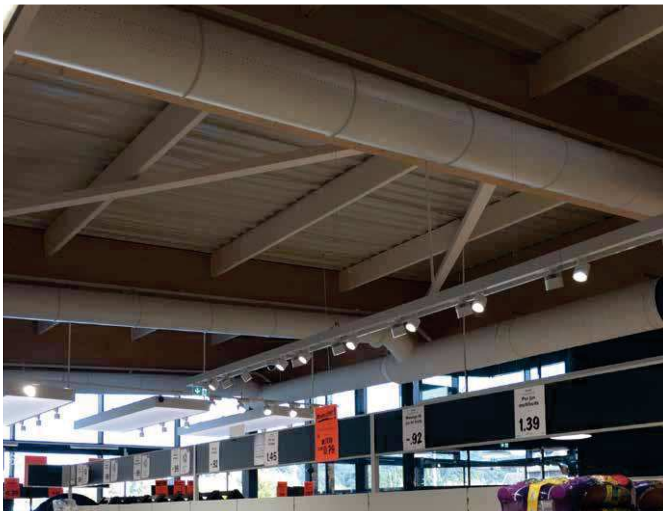
Diffuseur DHI METAL DHI METAL diffuser
